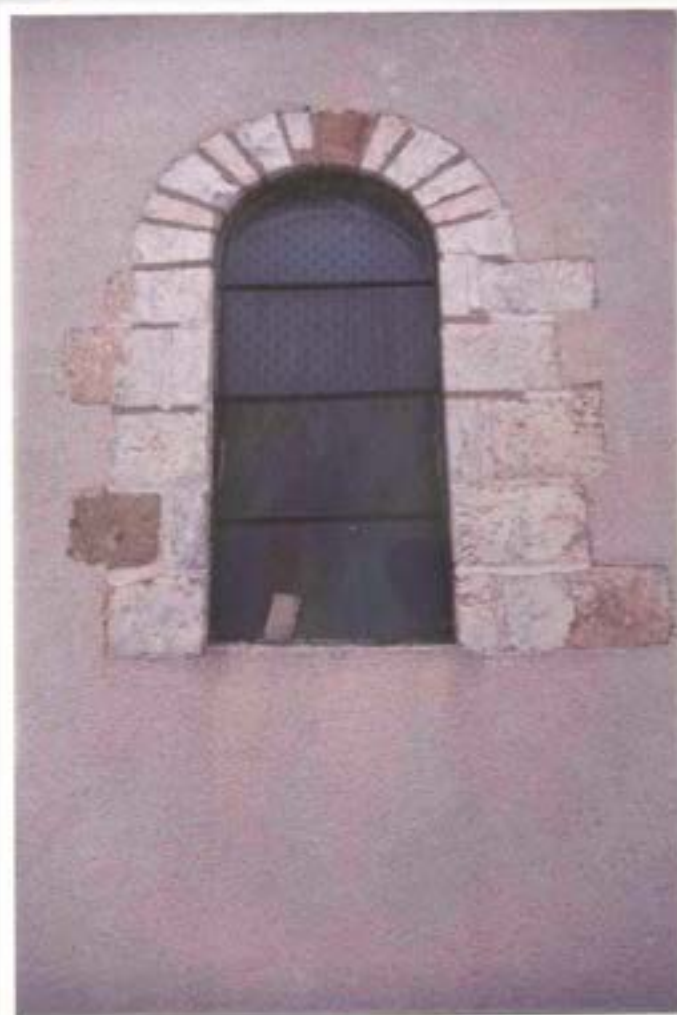
Fenêtre du mur latéral nord du choeur
