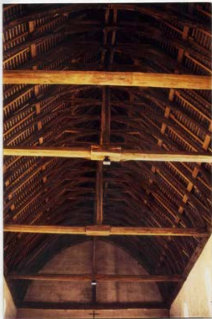
Charpente à entrails et poinçons apparents autrefois munie d'une voûte en lambris
