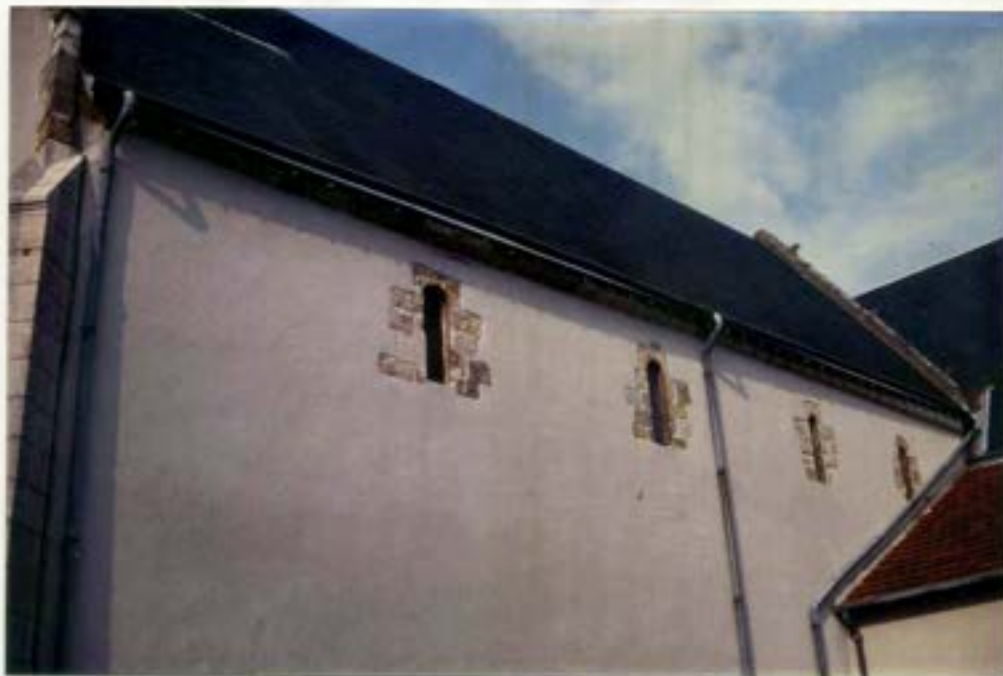
Mur sud de la nef
