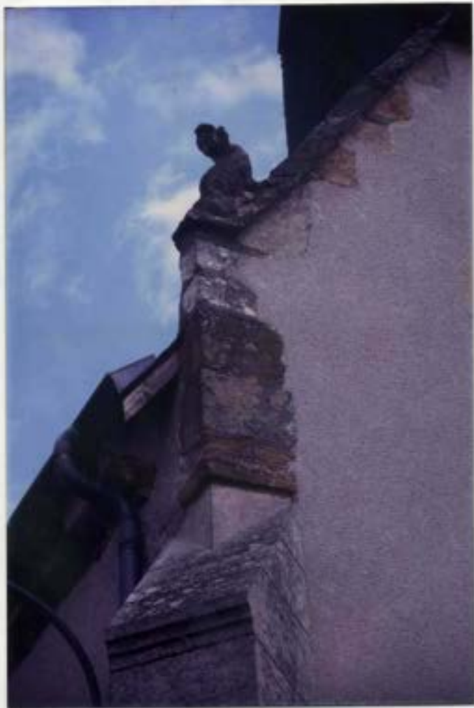
Base du rampant du pignon de la façade ouest de la nef (fin XV e s ou début XVI e s.)
